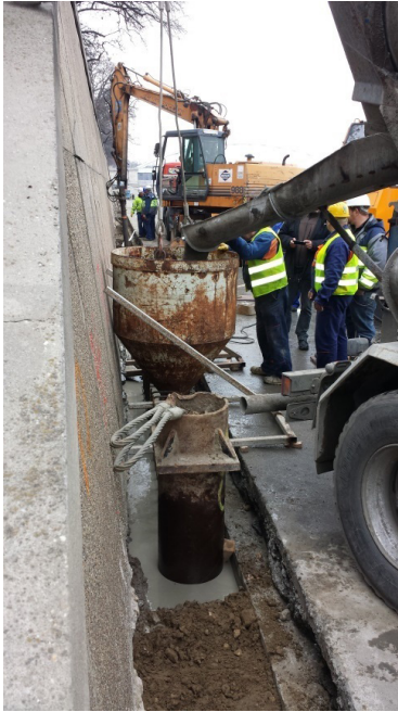
1. kép A résfal és a köpenyfal építése (Forrás: ATIVIZIG)
