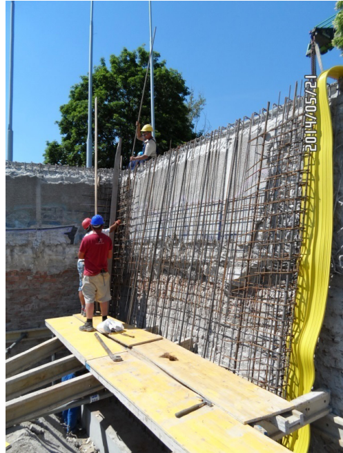
1. kép A résfal és a köpenyfal építése (Forrás: ATIVIZIG)
