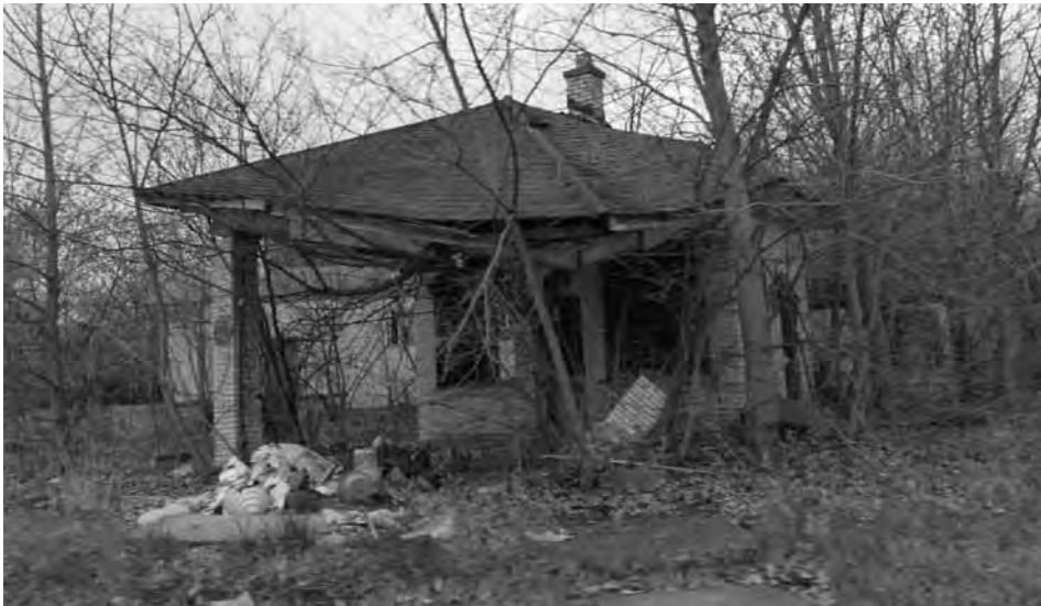
3. kép Elhagyott lakóépület Detroitban. Forrás: saját fotó Picture 3 Abandoned property in Detroit. Source: photo by the author
